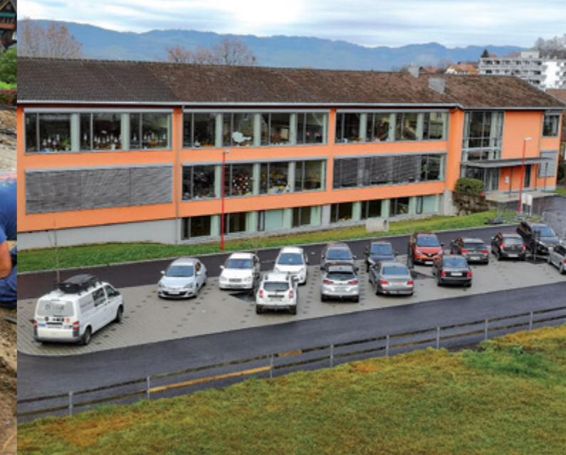
Neu gestalteter Parkplatz bei der Volksschule
