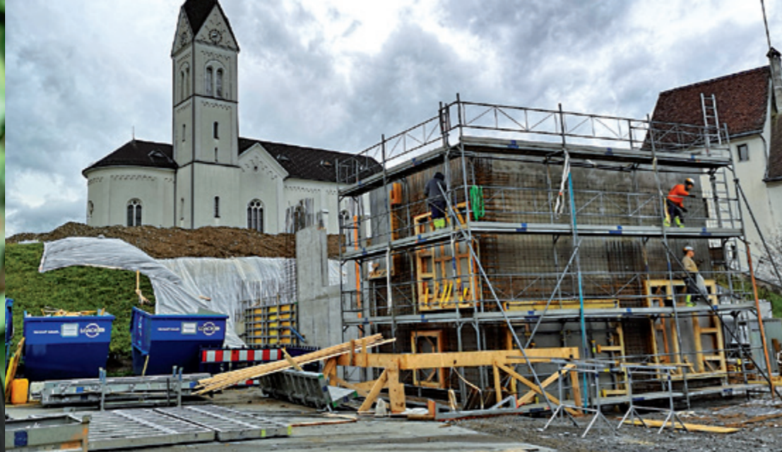
Bau des Kindercampus
